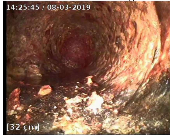
Grenledning i våtutrymme
