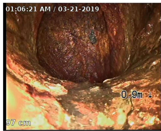
Anslutning mot stam och anslutande toalett
